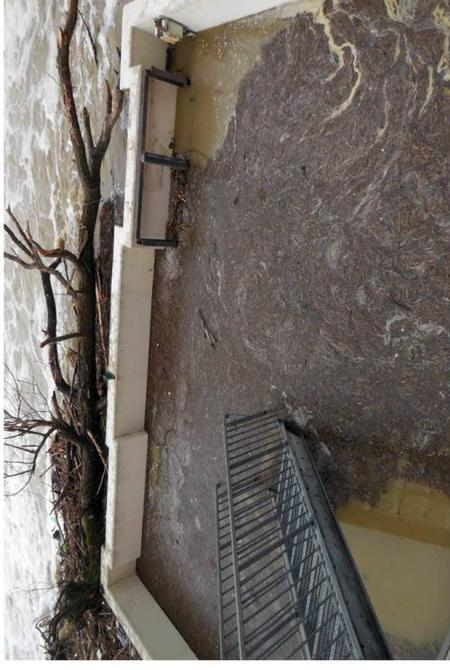
Crue du 6 mars noyage et blocage de l'entrée aval de la passe à bassins
