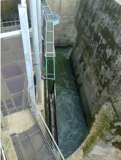
Sur la **partie aval** de la rampe, la sortie du débit d'attrait a été rigidifiée mais l'alimentation en eau est réalisée grâce à un tuyau souple, permettant le nettoyage de la partie basse de la rampe.
