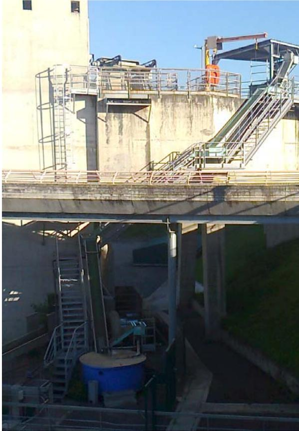
Au niveau de la **rampe amont**, un tube collecteur relie les 3 bassins de repos et permet leur vidange grâce à une vanne manuelle et individuelle de chaque bac.
