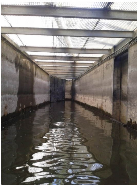
Photo 1 : Vue du canal collecteur
