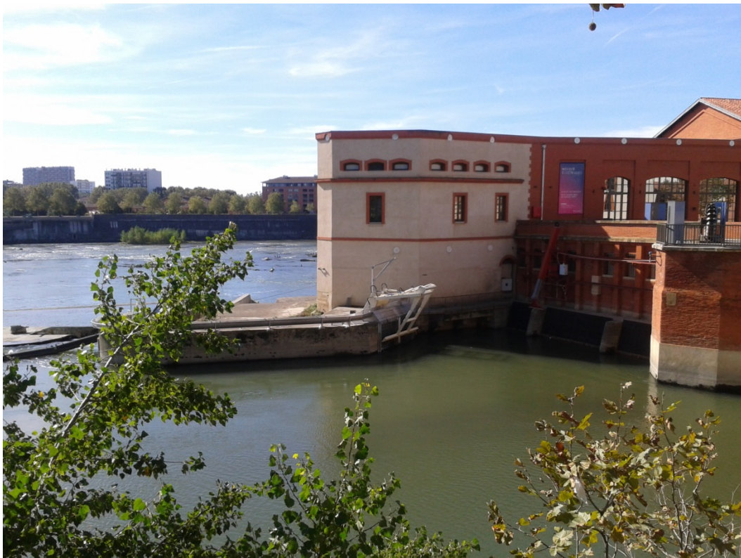
Photo 13 : Dégrilleur de la prise d'eau de la passe à poisson du Bazacle
