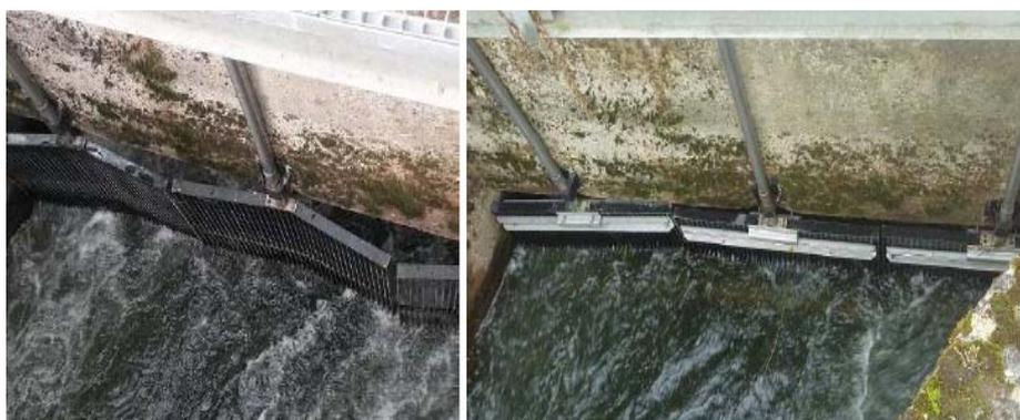
**Figure 2 : Photos des grilles pivotantes de Mauzac détériorées (à gauche) et réparées provisoirement (à droite), (Photos MIGADO, ECOGEA)**
