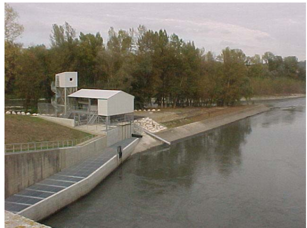
Photo 4 : La station de piégeage de Carbonne sur la Garonne
