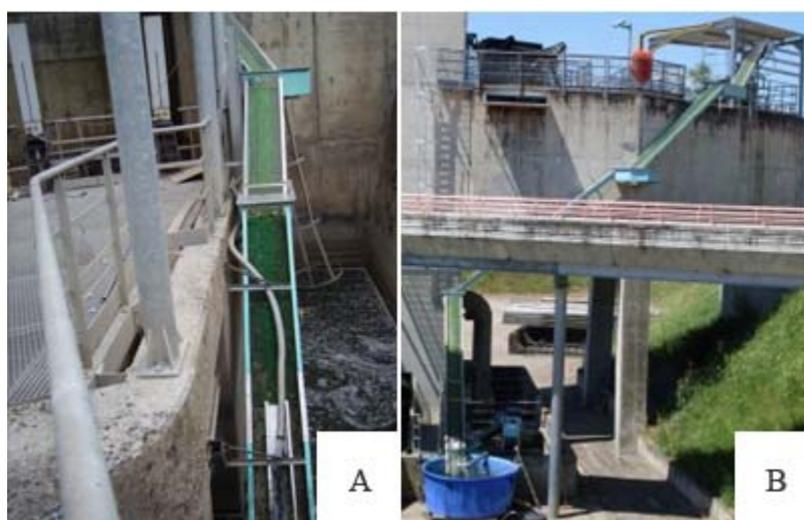
**Figure 23 : La passe à anguilles actuelle de Golfech. En A, la passe partie inférieure, en B, la passe partie supérieure.**
