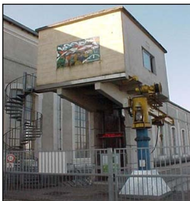
Photo 2 : Vue d'une partie de la tour de l'ascenseur à poissons de Tuilières
