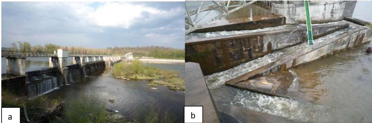
Photo 7 : Vue aval du barrage de Mauzac (a) et la passe à ralentisseurs du barrage (b).
