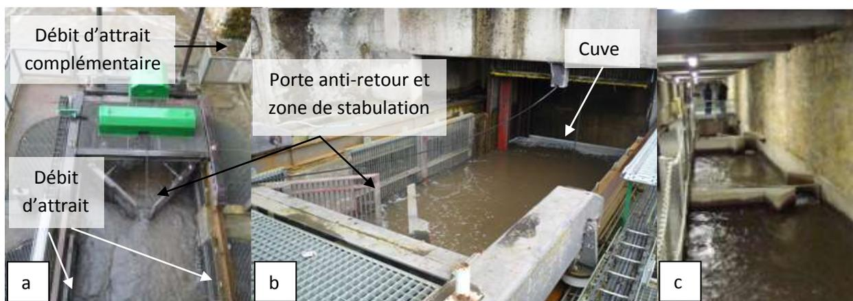
Photo 5 : Détail des organes de l'ascenseur à poissons de Tuilières : la nasse mobile (a), la cuve et le bassin de stabulation (b), la passe souterraine (c).
