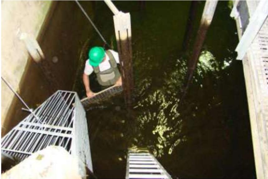
*Photo 10 : Le système de capture dans le bassin de la passe de Tuilières.*
