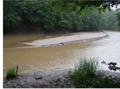
**Photo 9 : Accumulation de sédiments dans le barrage de la Bourboule (23-07-2007)**
