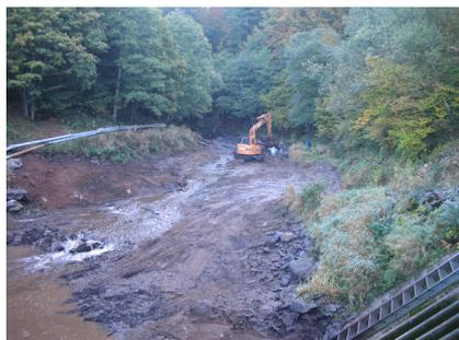
**Photo 59 : Curage de la retenue hydroélectrique de l'Eau Verte (07-10-2005)**
