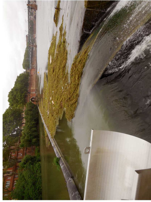
Accrochage à la drome de l'usine et dégrilleur bloqué par renouces du 28 juin au 12 juillet
