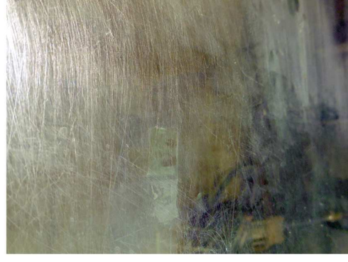
Détail de la vitre rayée à la passe à bassins
