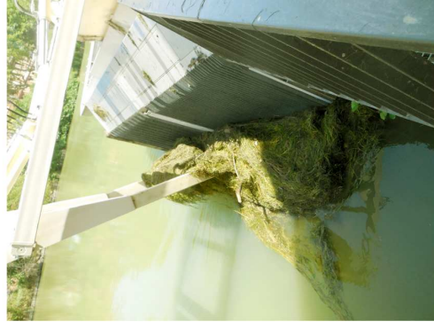
Accrochage à la drome de l'usine et dégrilleur bloqué par renouces du 28 juin au 12 juillet
