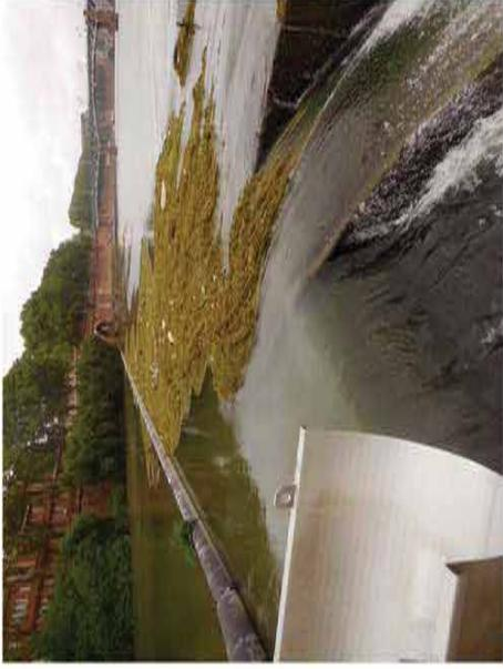
Accumulation à la drome de l'usine et dégrilleur bloqué par renoncules fin juin et juillet
