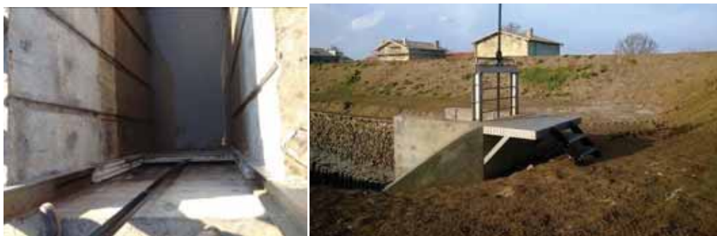
Figure 42 : Ouvrage modifié, automne 2013. Source : Anteagroup, 2013.
