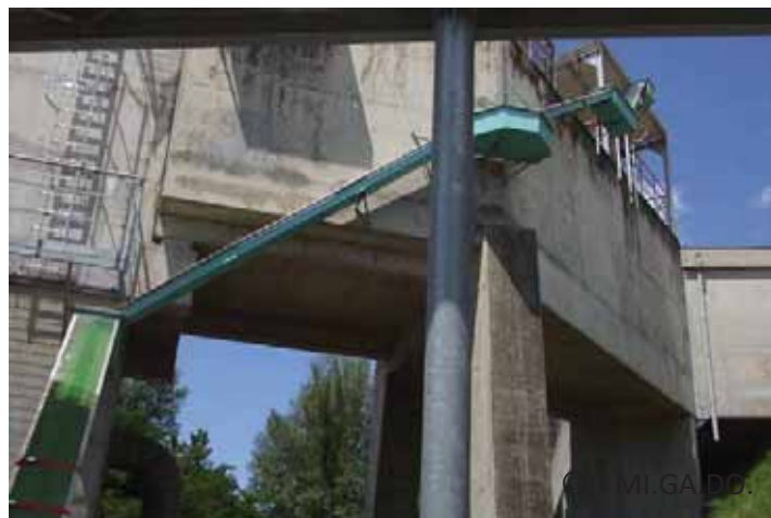
Figure 20 : Passe à anguilles de Golfech.
