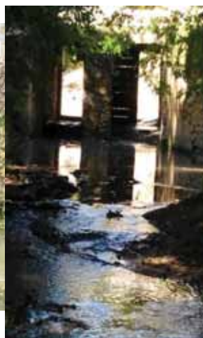
Figure 39 : Impact des ouvrages à la migration de montaison sur la Soulège (a), premier ouvrage aval Moulin de Moustelat avant ouverture des vannes et après ouverture des vannes en 2015 (b).
