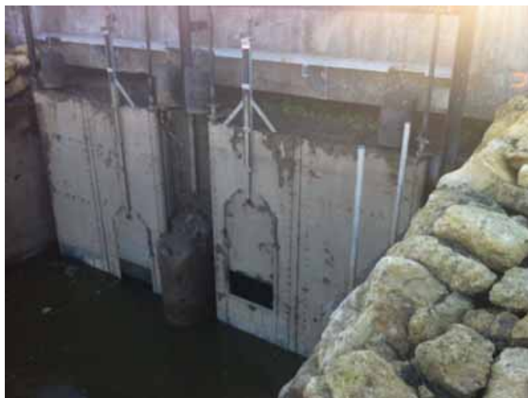
Figure 43 : Porte à flot de Despartins aménagée avec une vantelle haute et une vantelle basse.
