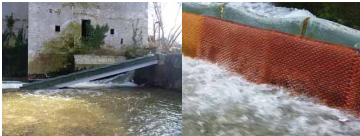
Figure 42 : Franchissabilité des obstacles à la montaison sur la Gélise (a), passe à canoë et nouveau tapis de reptation (b)
