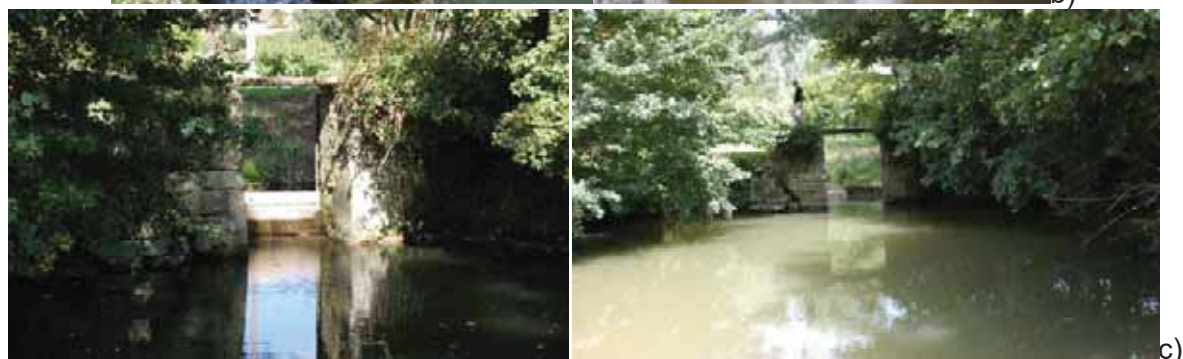
Figure 38 : Impact des ouvrages à la migration de montaison sur le Lisos (a), premier ouvrage aval Moulin Rabeze avant ouverture des vannes et après ouverture des vannes en 2009 (b), troisième ouvrage Moulin du Haut avant mise en place du calendrier de gestion des vannes et après gestion à partir de 2009 (c)
