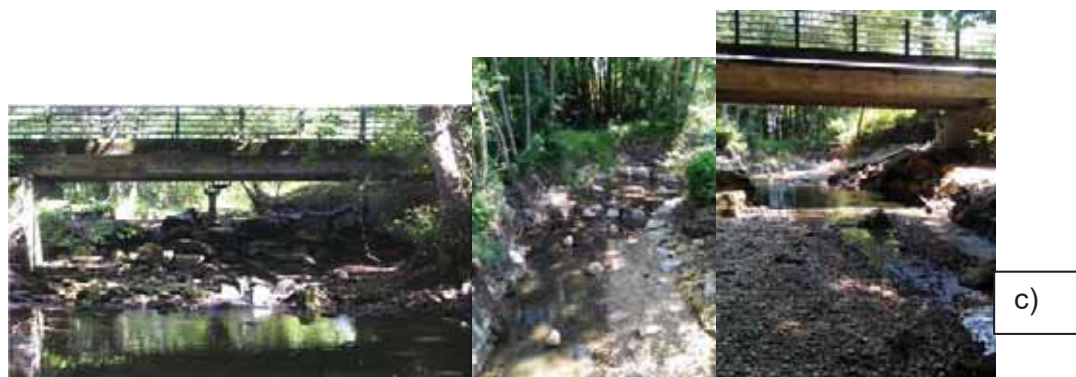
Figure 40 : Impact des ouvrages à la migration de montaison sur Barailler/Eyraud (a), arasement de l'ouvrage aval, Moulin du Coutou c), démantèlement et réaménagement du seuil de répartition du Pont de Chadeau d)
