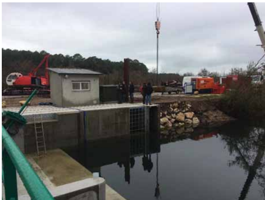
Figure 71 : Sortie de la passe à poissons (grillagée) et échancrure de l'emplacement de la caméra en amont.
