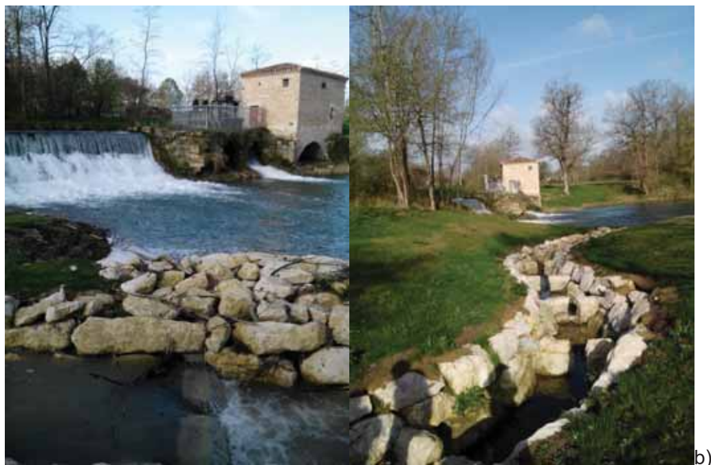
Figure 41 : Evaluation de l'efficacité de la rivière de contournement sur le site du Moulin de Castels (Tarn et Garonne) (a), site aménagé (b)
