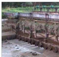
Des clapets à axe horizontal
