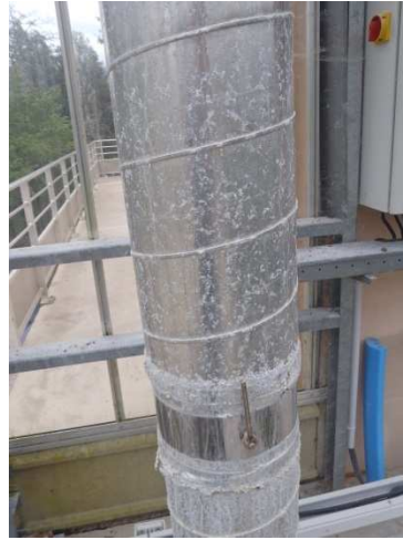
Photos : développement de mousses et vieillissement prématuré
