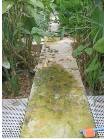
Photos : développement de mousses et vieillissement prématuré
