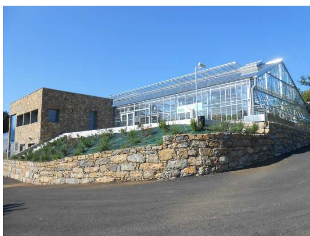
Photo : exemple de Station d'épuration Organica
