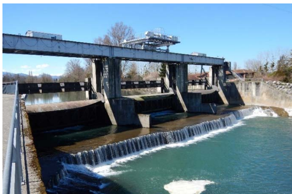
Photo 3 : Barrage de Rodère,
