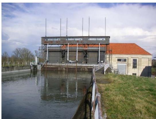
Photo 2 : Canal d'amenée et centrale de Pointis
