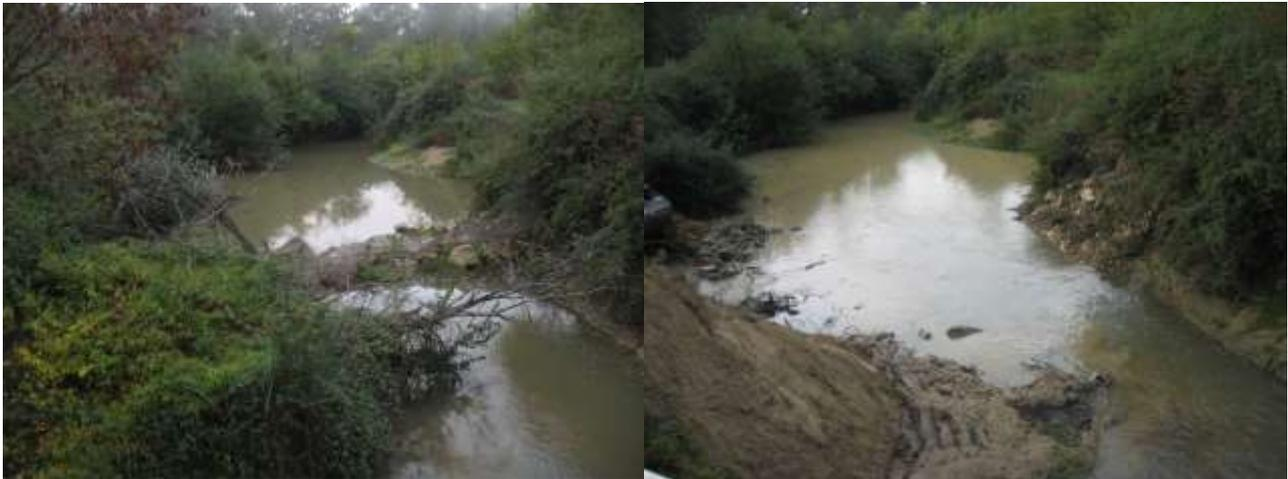
Figure 7 : Exemple d'effacement de seuil dans le seuil avec création d'un radier à l'amont
