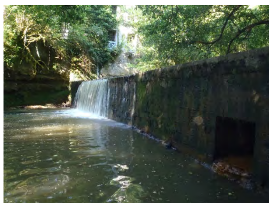
Figure 53 - Seuil du moulin du Batan sur la Douze, à Roquefort (MIGRADOUR)
