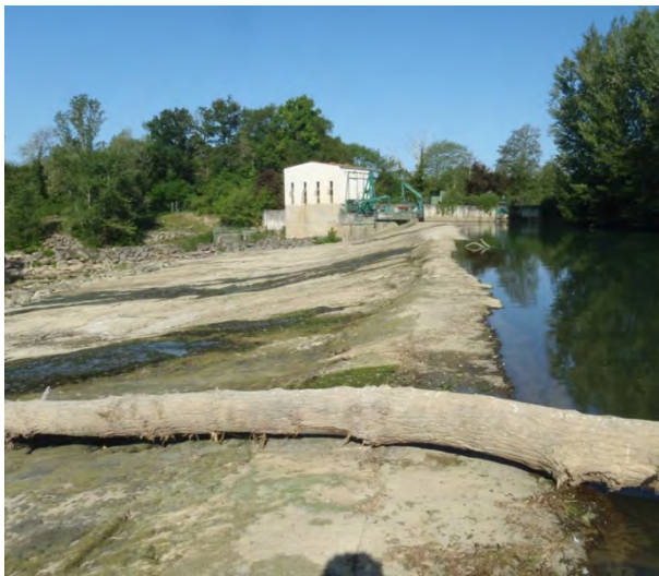
Figure 23 – Barrage de Saint Maurice sur Adour (MIGRADOIR)
