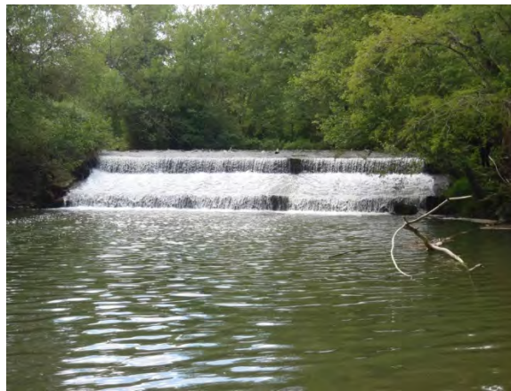
Figure 39 – Seuil du moulin de Préchacq-les-Bains sur le Louts (MIGRADOIR)
