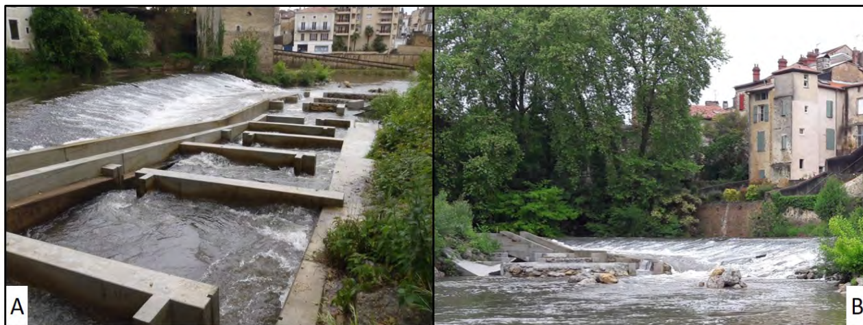
Figure 46 – Seuil de la Minoterie de Mont-de-Marsan sur la Midouze vu depuis l'amont (A) et depuis l'aval (B) (MIGRADOUR)
