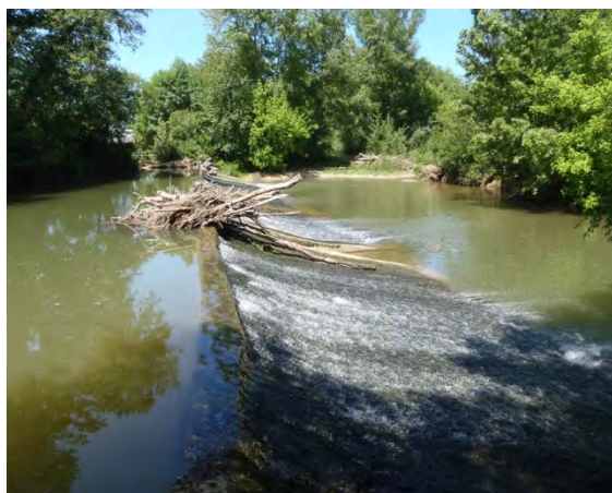
Figure 42 - Seuil de Toulouzette sur le Gabas (MIGRADOIR)
