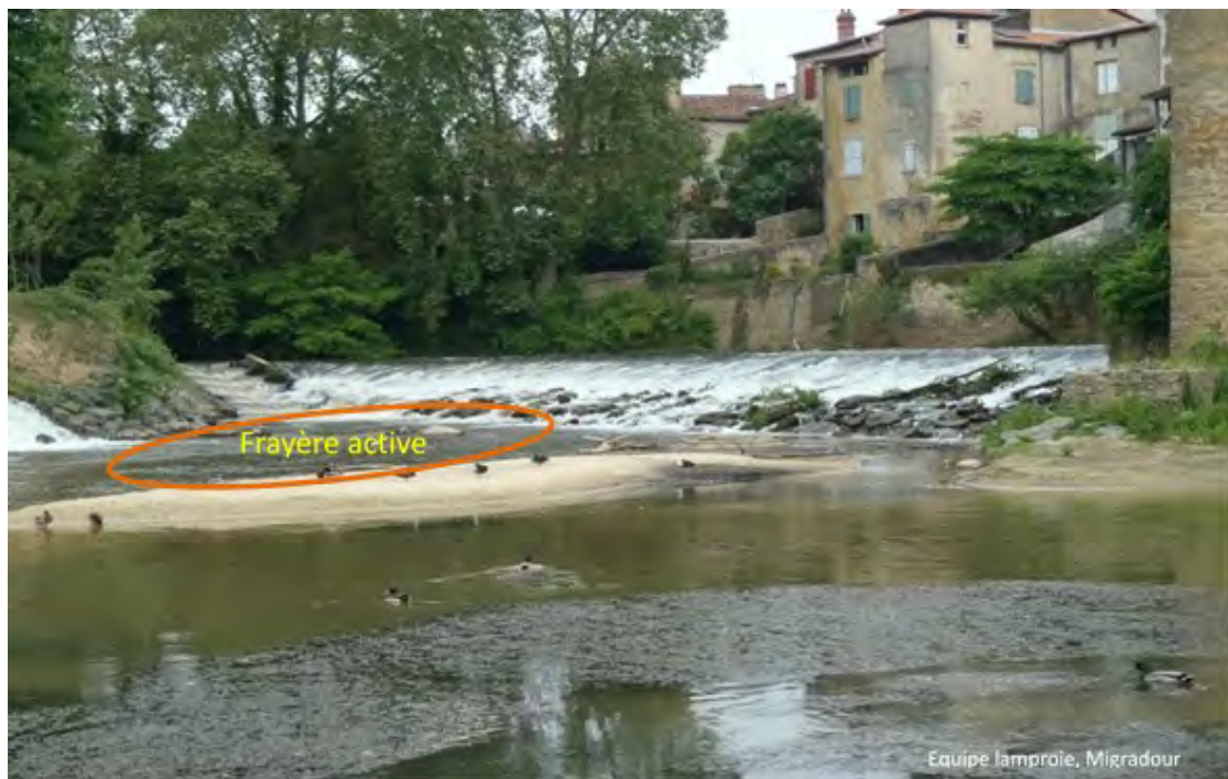
Figure 47 - Forte concentration de nids observée à l'aval direct du seuil de Mont-de-Marsan sur la Midouze, lors du suivi réalisé en 2012 (MIGRADOUR)
