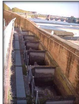
**Figure 6 : Photos de la chaussée du Bazacle et de la passe à bassins.**
