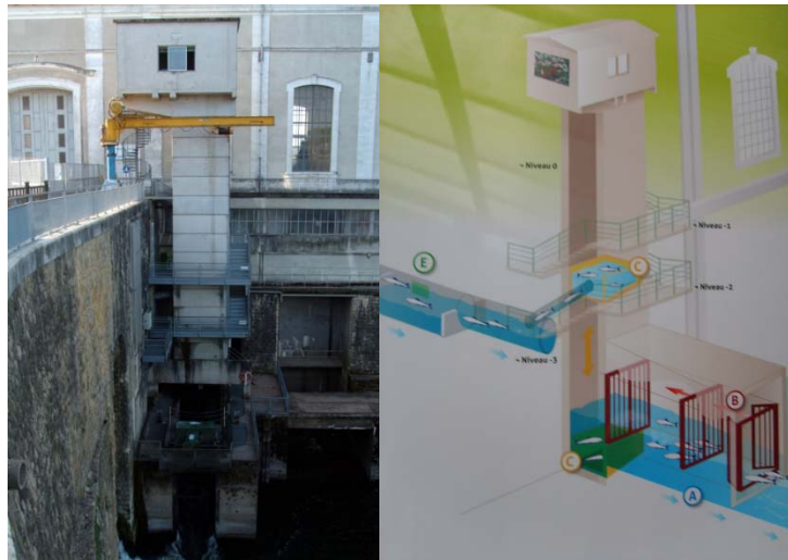
Photo 6 : Ascenseur à poissons de Tuilières.
