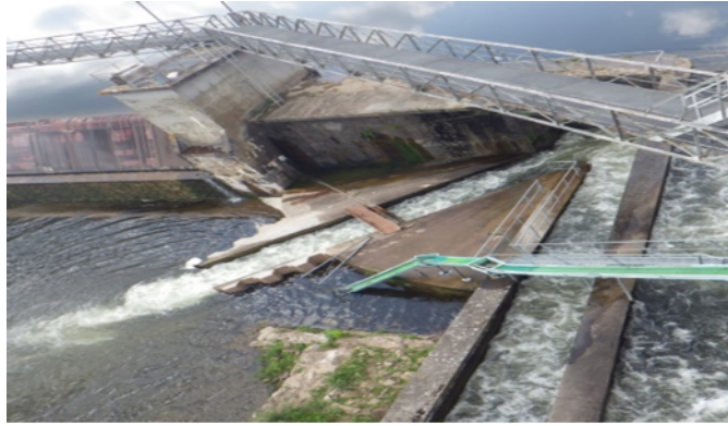
Photo 11 : Passe à ralentisseurs et rampe à anguilles de Mauzac.
