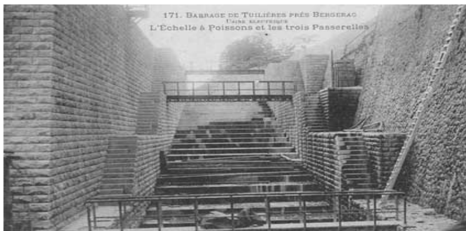
Photo 5 : La passe à bassin originelle de Tuilières en rive gauche.
