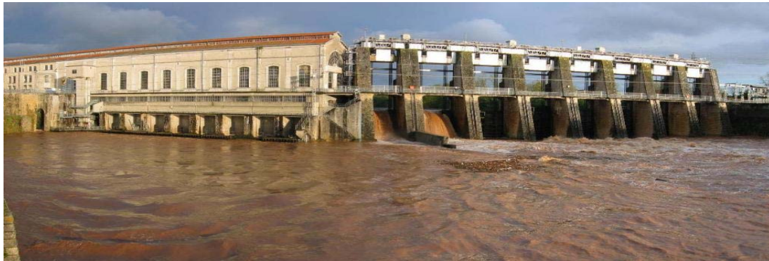
Photo 4 : Barrage de Tuilières vu de l'aval.
