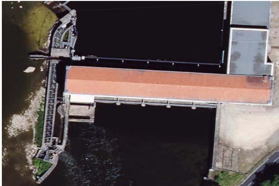
Photo 12 : Passe à poissons de l'usine de Mauzac.
