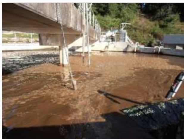
Figure 2: Ensemble des capteurs permettant le suivi du bassin biologique
