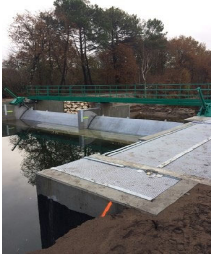
Figure 16 : Photo de la nouvelle écluse (vannes fermées)*
