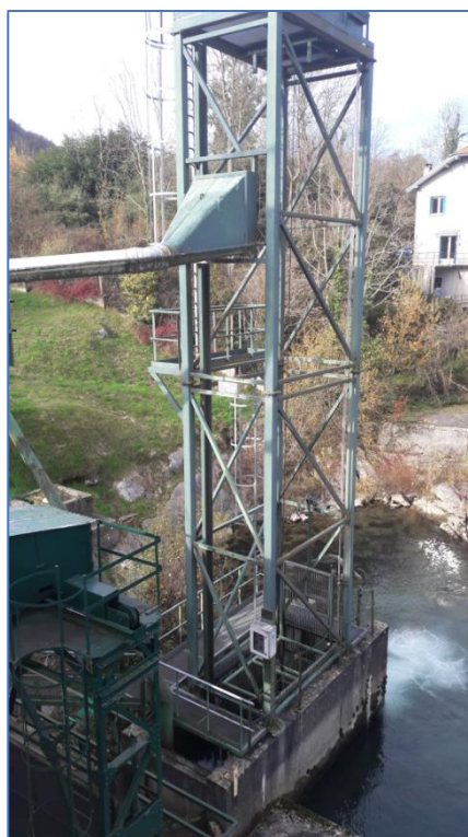
Figure 4 : Vue de l'ascenseur à poissons du barrage de Castet
