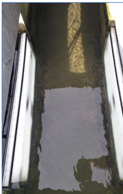
Figure 5 : Vue du dessus du canal de fuite de l'ascenseur à poissons avec la présence des 2 panneaux LEDS
