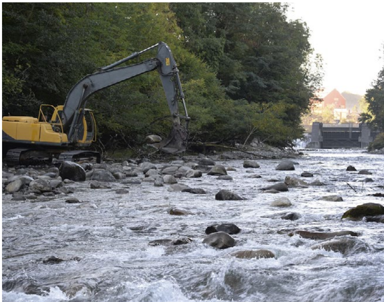
Travaux de diversification du lit mineur de la Neste à Sarrancolin dans les Hautes-Pyrénées © TAILLEFER Didier - AEAG
