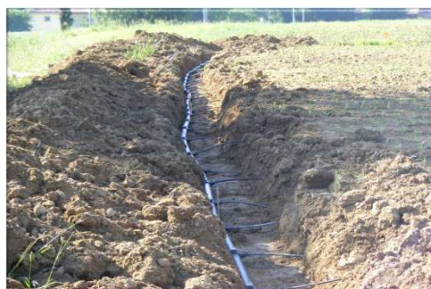
Figure 2 : Illustrations du goutte-à-goutte de surface et du goutte-à-goutte enterré (CA40)
